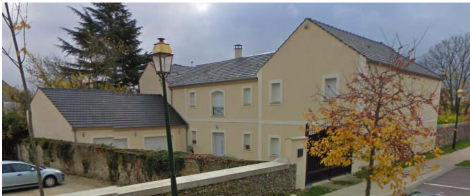
Partie Nord – Rue des Maronniers : 4 logements (32,1 ares) - (source : google streetview)
