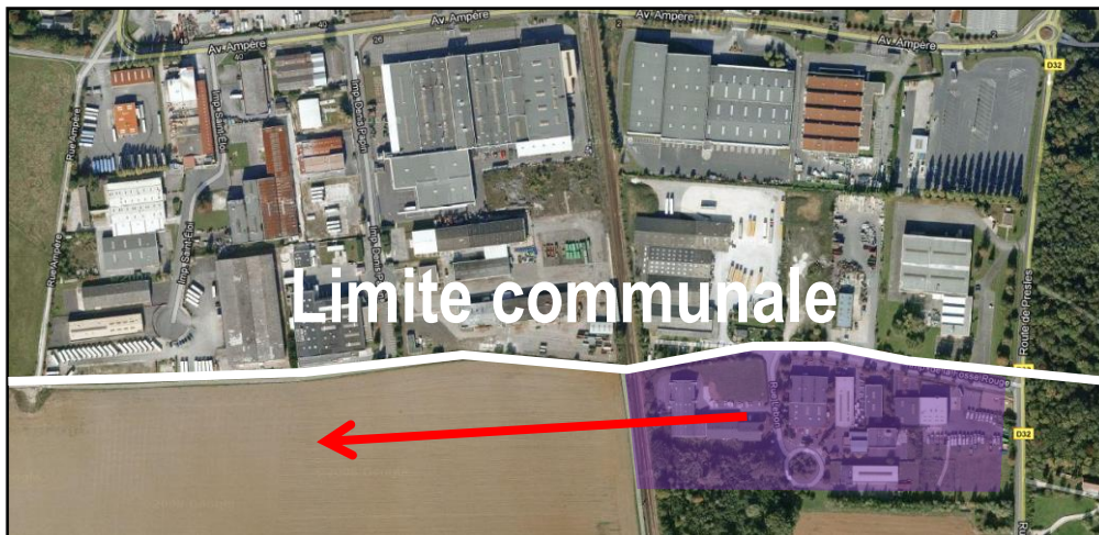
Vue aérienne de la zone d'activités.
